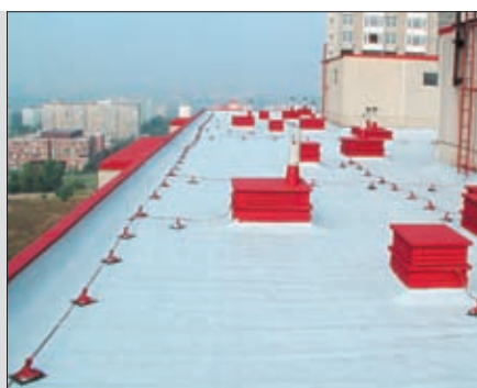
Stav střechy a klempířských prvků po aplikaci hmoty SANAKRYL TOP (UV)
