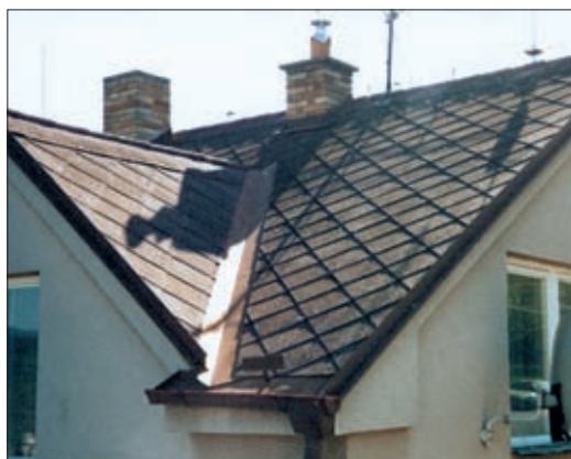
Stav střechy před aplikací - stáří 23 let.
