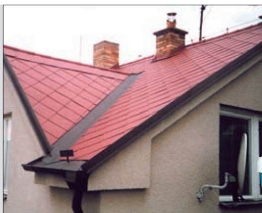
Stav střechy po aplikaci.
