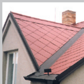
Eternitová krytina po nátere
